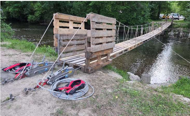
Die ZSO baut Brücken im Schachen Brugg (Bild: RFO Baden).
